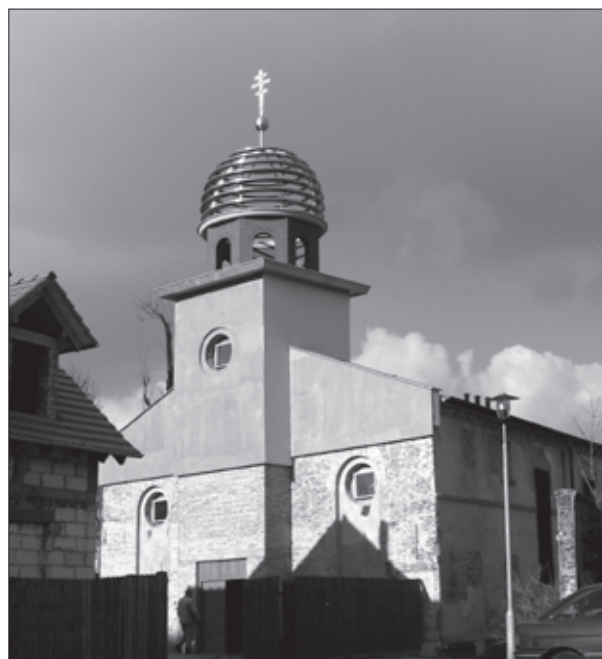
Budowa nowej cerkwi w Zielonej Górze. Fot. M. Tujdowski (2007)
